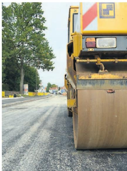
Die Tragschicht ist fertig, am kommenden Montag kommt die Asphaltkolonne, um die Fahrbahndecke zu ziehen. Danach erfolgen die Markierungsarbeiten. Am Donnerstagabend sollen die Absperrungen beseitigt werden.
